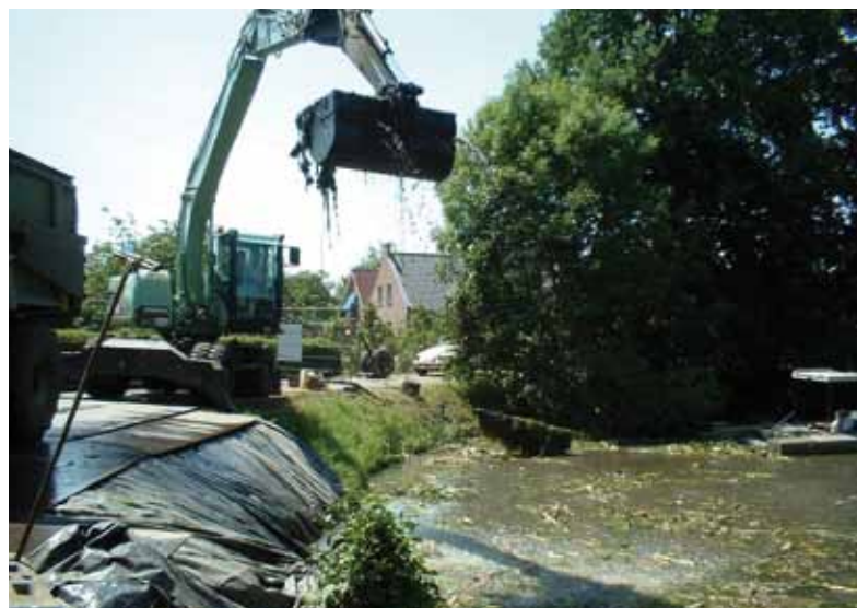
De bagger die wordt opgehaald moet ergens worden gestort.
