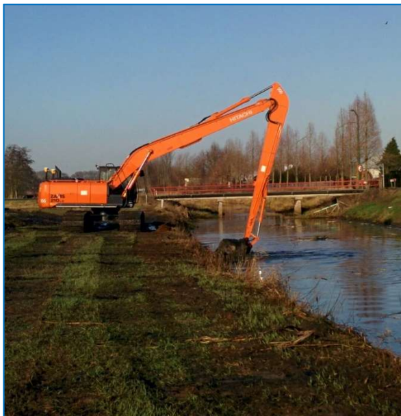
Baggeren met een grijperkraan vanaf de kant
