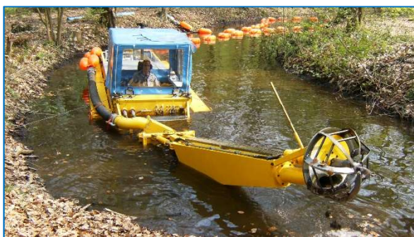
Hydraulisch baggeren met een cutterzuiger
