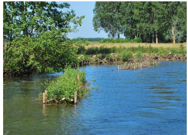
Aanvullende inrichtingsmaatregelen zoals aanbrengen takkenbossen (links) of zogenaamde vissenbossen (rechts).
