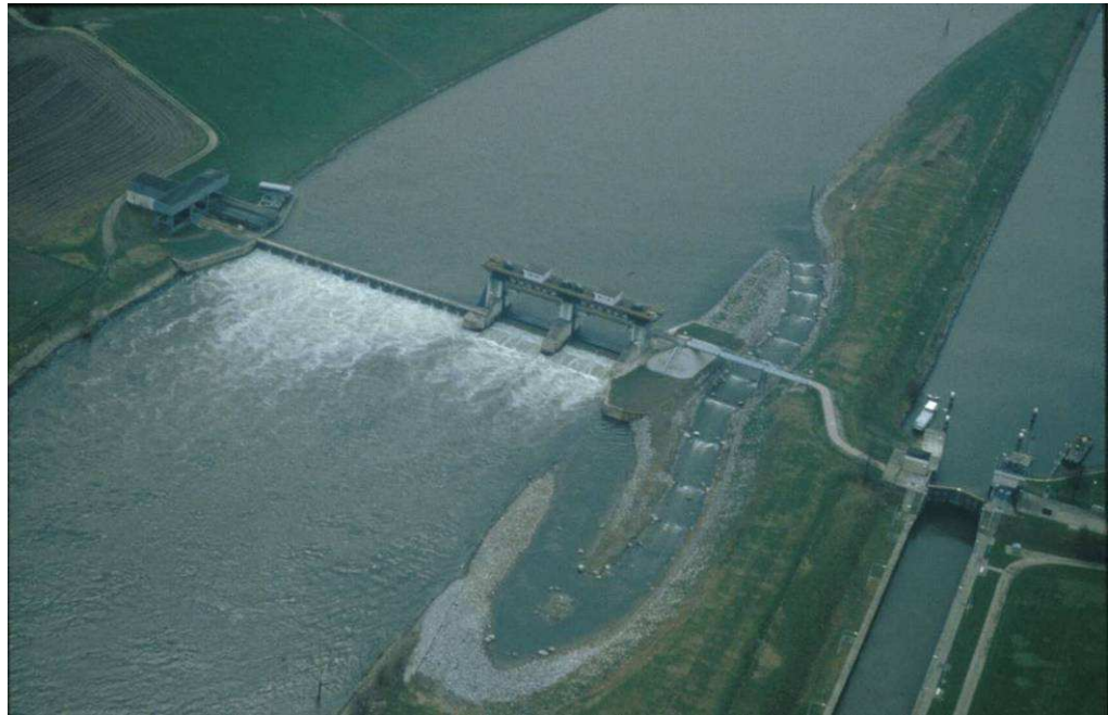
Vispassage in de Maas. De vistrap ligt tussen de stuw (links) en de scheepvaartsluis (rechts). Foto: Sportvisserij Nederland.
